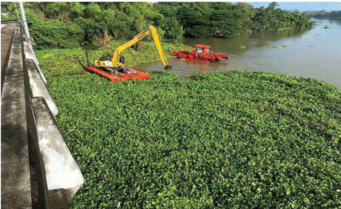
รูปที่ ๓ การปฏิบัติงาน ณ บริเวณสะพานกอบกุล
