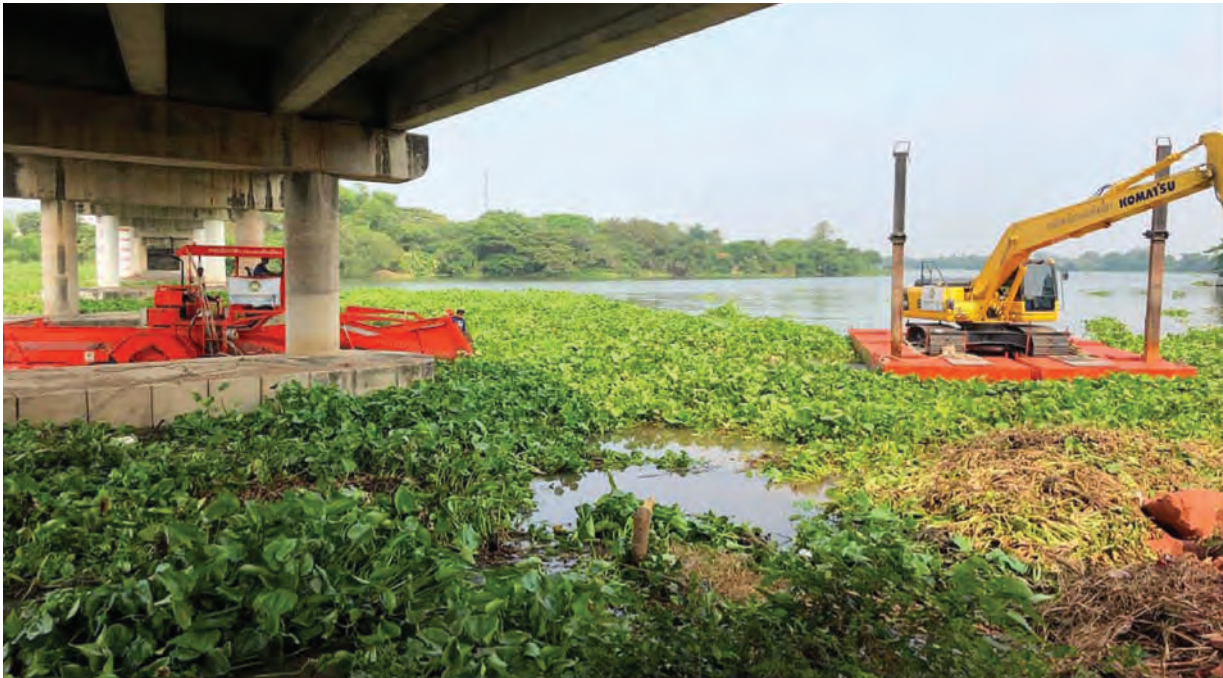
รูปที่ ๑ การปฏิบัติงาน ณ บริเวณสะพานกอบกุล
