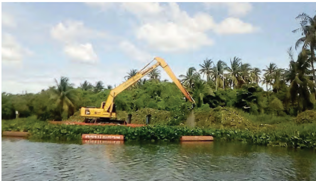
รูปที่ ๑ การปฏิบัติงาน ณ บริเวณสะพานทรงคนอง
